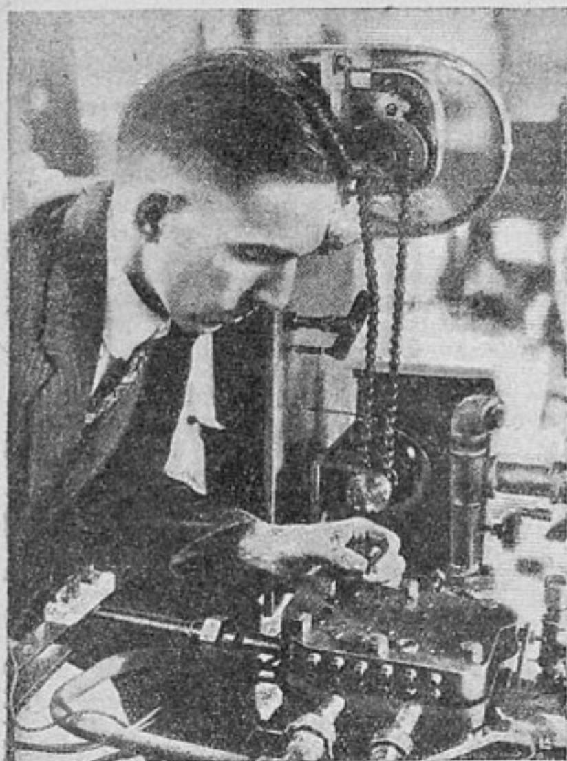
Наблюдение за процессами, происходящими в цилиндре двигателя во время работы
